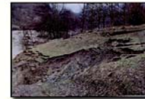
Зсув ґрунту на березі р. Шолурка, березень 2001 р.
